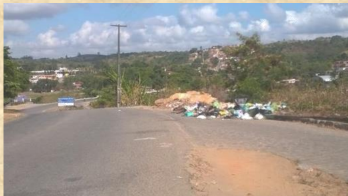
Figura 14. Disposição inadequada de resíduos.
